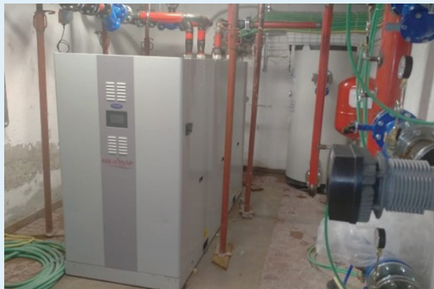
Erna: stookruimte na de werkzaamheden van de nieuwe warmtepomp
